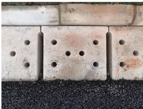
图 2 设置快速排水通道的预制盖板
