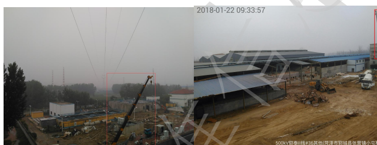
图 13 吊车_扬臂部分露出
