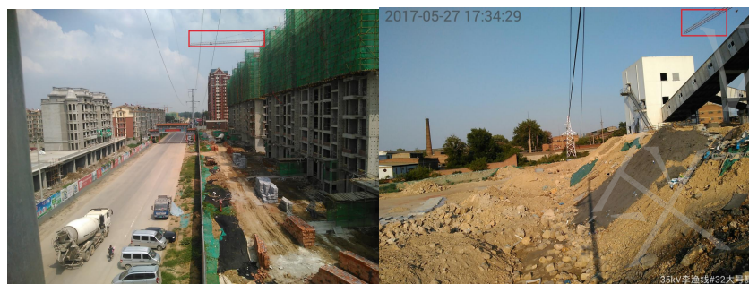
图 9 塔吊部分吊臂
