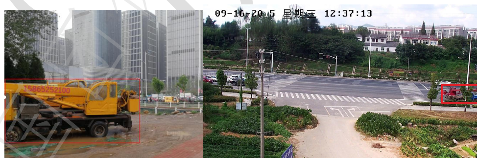
图11 吊车车体部分露出
